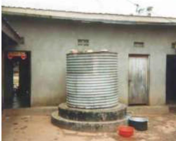
Uganda: Sistema con tanque de hierro corrugado
