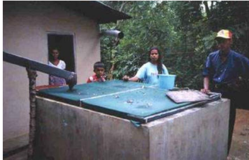
Sri Lanka: Sistema con tanque de concreto
