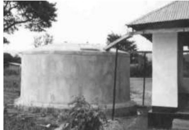
Tanzania (Villa Ruganzu): Sistema con tanque de ferro-cemento
