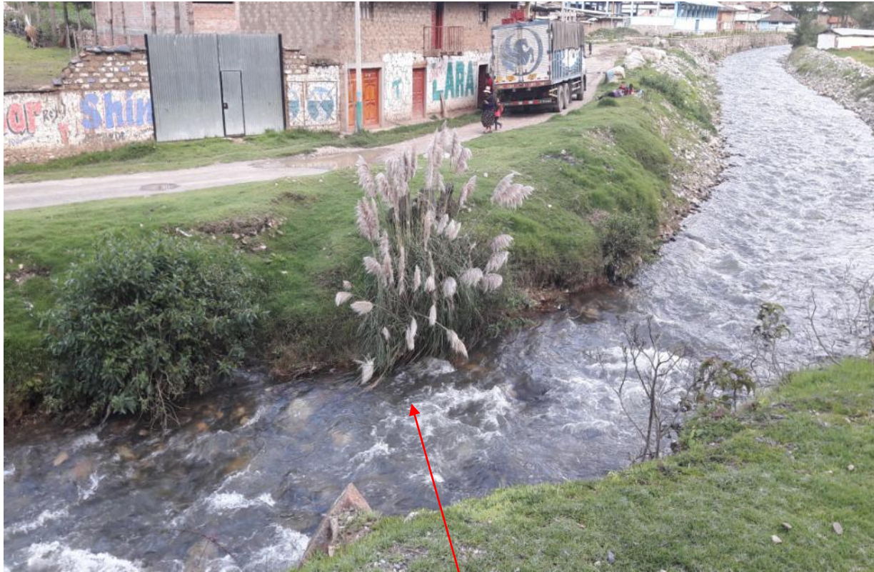
Emisor del desagüe en la localidad de Conchucos descarga al río Tulpi.
