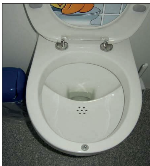
Aparatos sanitarios mejorados con desviador de orina
