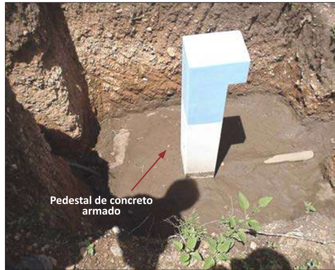
Tubo rompe carga terminado y en funcionamiento
