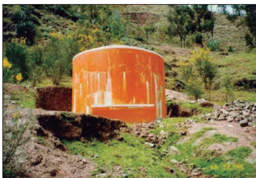
Agrietamientos y exudaciones observadas en reservorios
