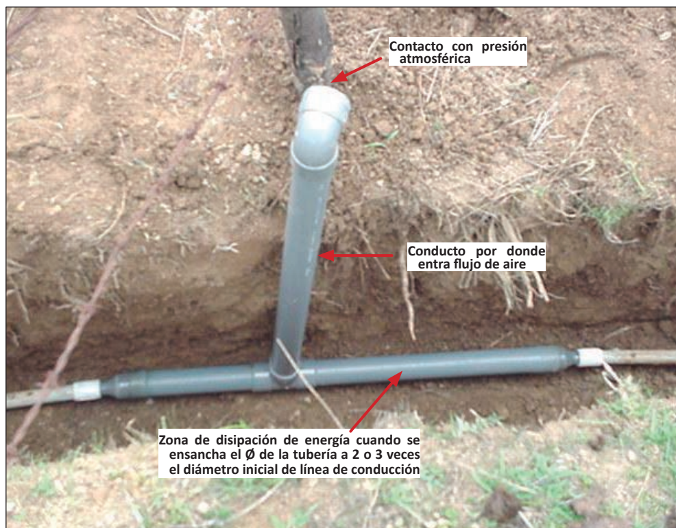
Proceso constructivo del tubo rompe carga
