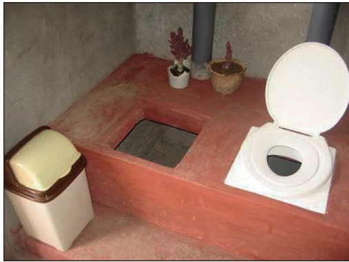
Aparatos sanitarios con desviador de orina móviles
