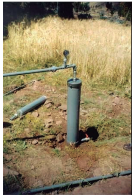
Dispositivo de flotación simplificado sin cámara húmeda
