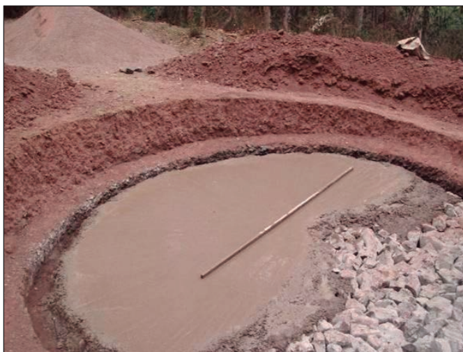
Empedrado y colocación de piso
