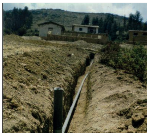
Construcción de buzón
