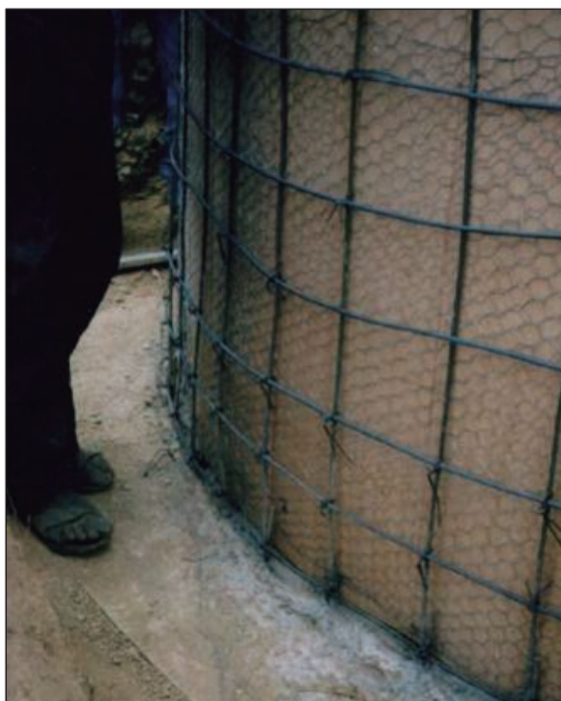
Armado de refuerzo con encofrado
