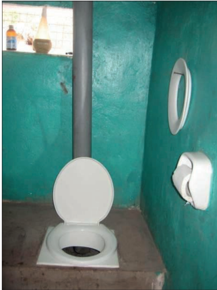
Aparato sanitario móvil con collarín
