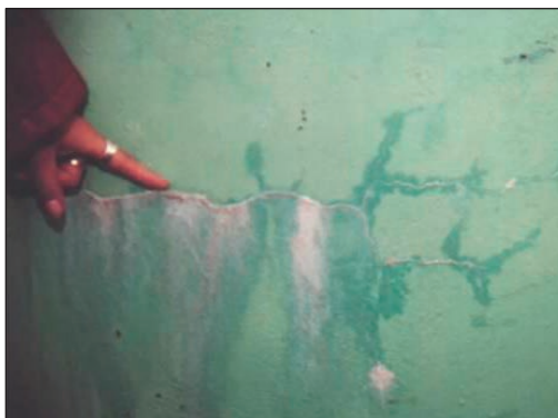
Agrietamientos y exudaciones observadas en reservorios
