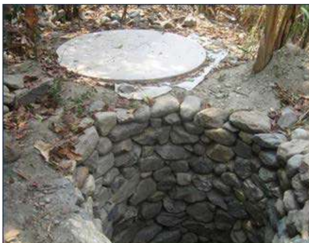
Pozo de absorción con mampostería de piedra
