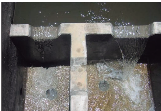
Vertedero triangular en funcionamiento
