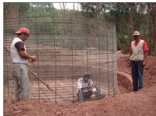
Armado de refuerzo sin encofrado
