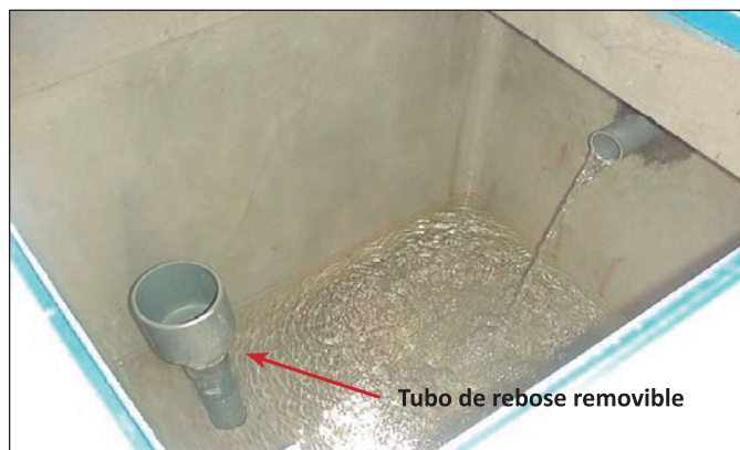
Captación: interior de cámara húmeda
