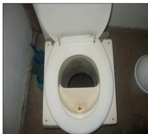
Aparatos sanitarios mejorados con desviador de orina
