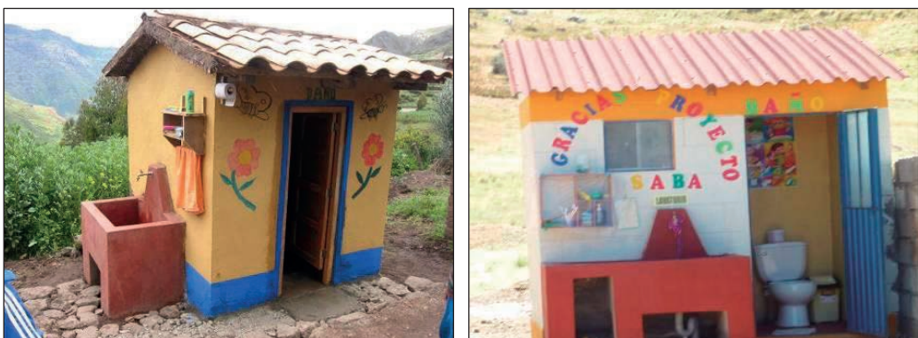
Módulos sanitarios con sistema de arrastre hidráulico, Cusco
