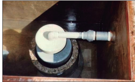
Anillo de concreto en alto y bajo relieve que impide el movimiento lateral del pistón
