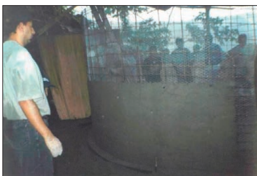
Pañeteo sin encofrado
