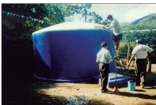
Reservorio de ferrocemento concluido
