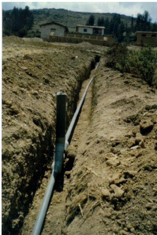
Tendido de red colectora
