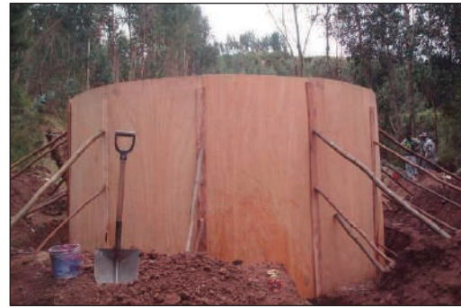
Estructura de madera para encofrado
