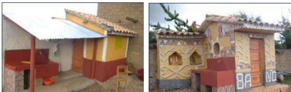
Lavaderos multiusos, ubicados cerca al servicio higiénico, Cusco.
